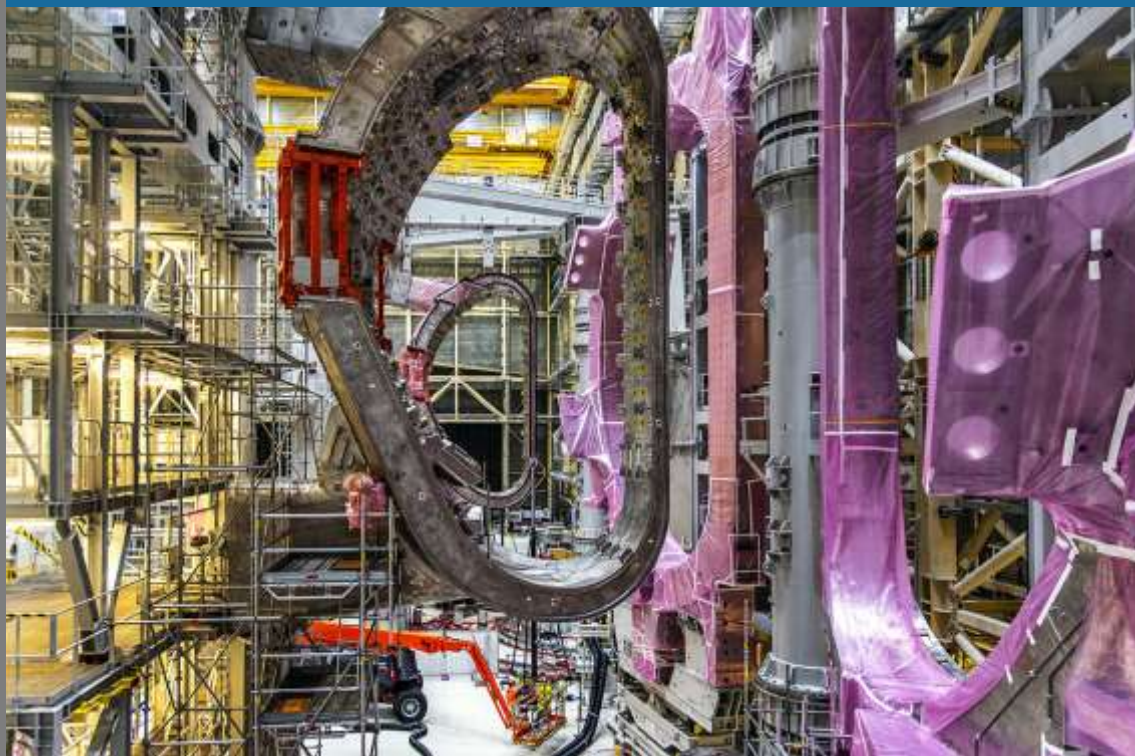
Τοποθέτηση των επί μέρους τμημάτων σχήματος D που αποτελούν το θάλαμο κενού του ITER (iter.org)
